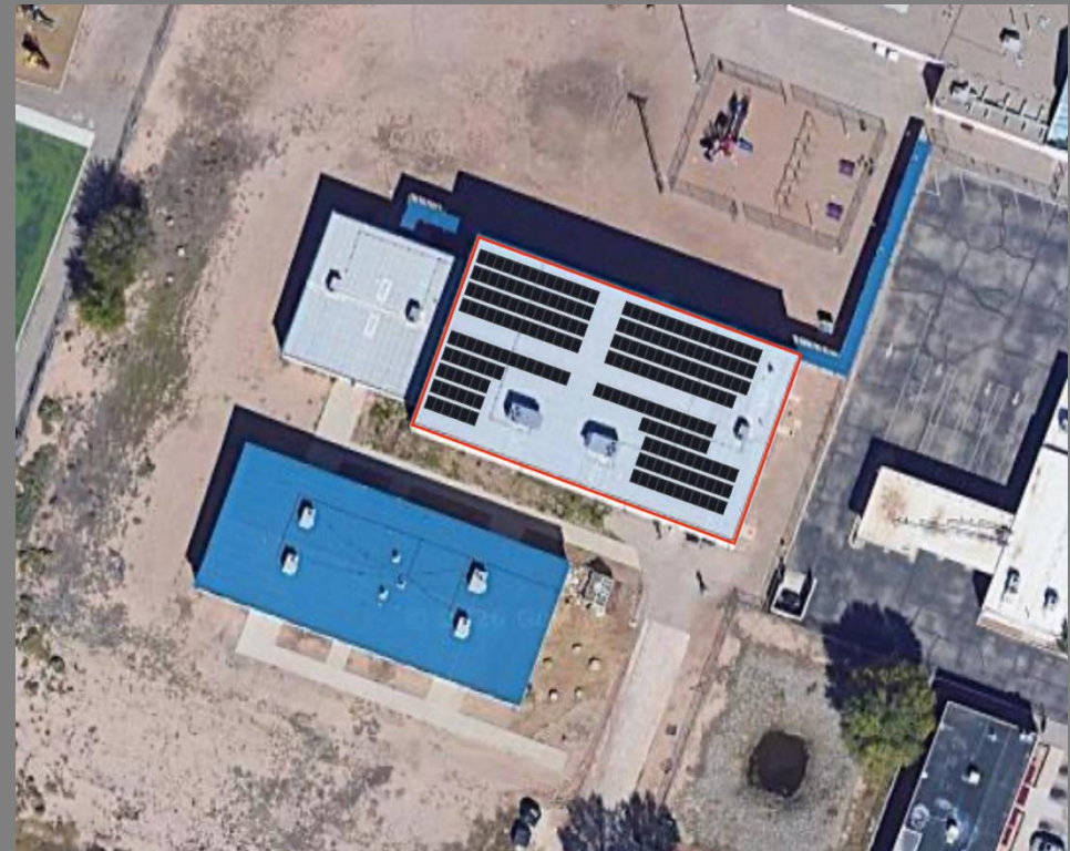
Gym Rooftop Array 125 kW DC Est 85% Offset
